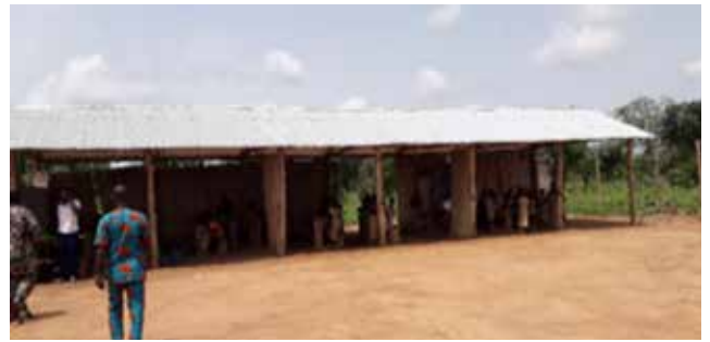
EPP DJOGBEDJI avant les travaux de construction
