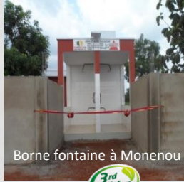
Nouveau forage à Tokpli
